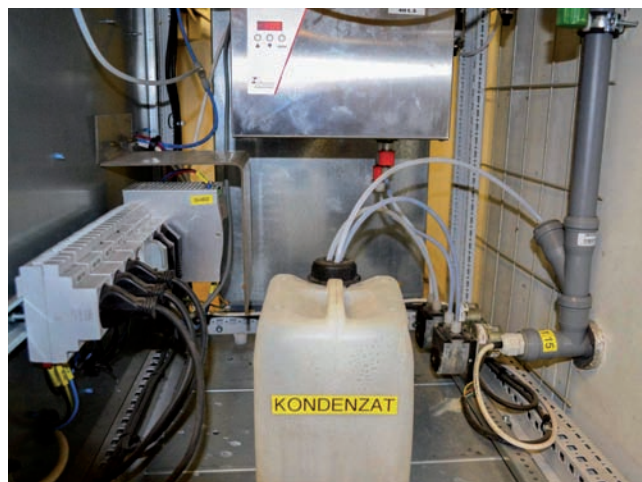
Chladnička na schladenie plynnej vzorky. Skondenovaná voda zo vzorky sa odsaje do plastovej nádoby.
