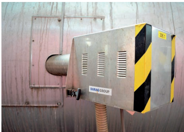
Meranie prietoku spalín na potrubí recispalín blokov. Ultrazvukový analyzátor Durag.
