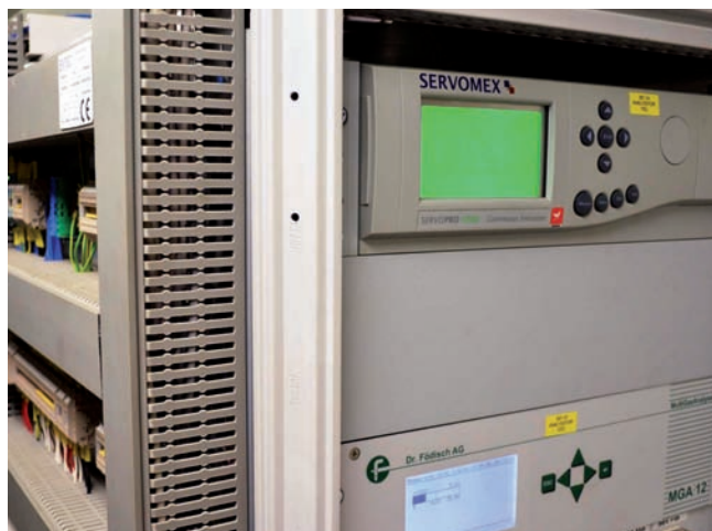
SO 2 , CO, NO x a suchý O 2 meria na odsírení analyzátor Servomex ServoPro 4900. Hodnoty CO 2 meria analyzátor Dr. Födisch MGA 12.
